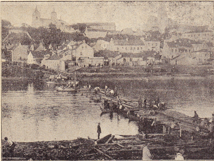
Construction d'un pont de circonstance.
